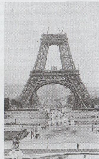
La tour Eiffel en cours de construction (1888).
