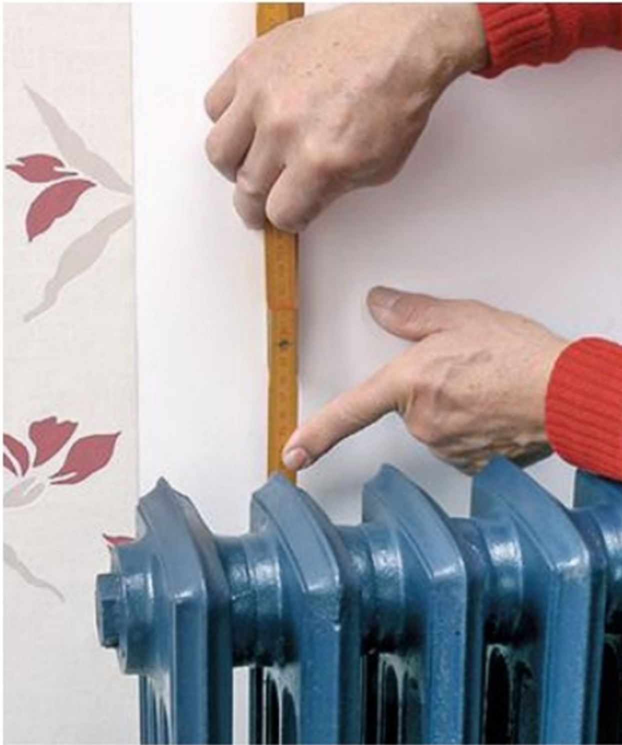
1 Le dernier lé posé arrive au niveau du radiateur et le suivant devra contourner la première fixation. Mesurez son emplacement depuis le sol.
