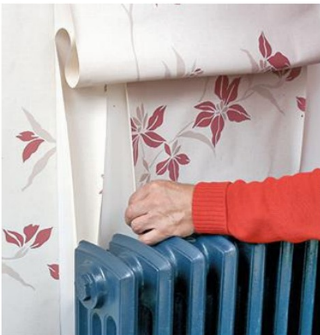
7 Repliez la base du lé sur elle-même et dépliez-le en faisant glisser la fente sur la console. Tirez délicatement sur le papier pour ne pas le déchirer.
