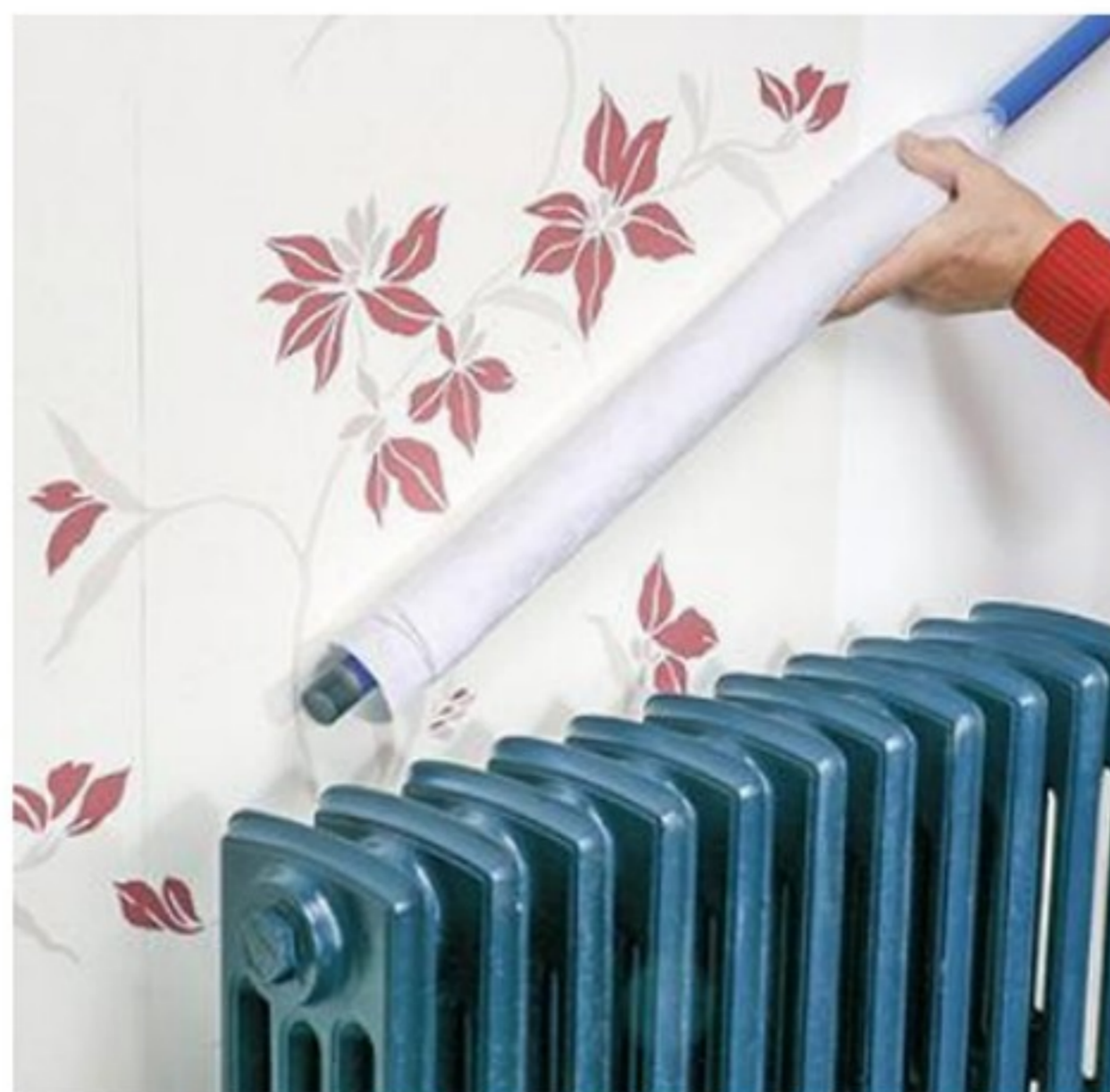
8 Maroufflez avec le manche à balai de haut en bas et latéralement. On a enroulé une nappe en papier pour avoir la bonne épaisseur. Répétez le process avec l'autre fixation et le lé suivant.
