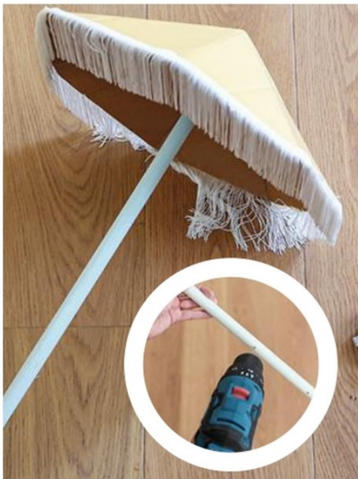
16 Collez le manche de l'ombrelle à sa «toile». Pour le fixer, prépercez-le en deux points : à 5 et 15 cm de son extrémité. Cela évitera d'éclater le bois au moment du vissage.
