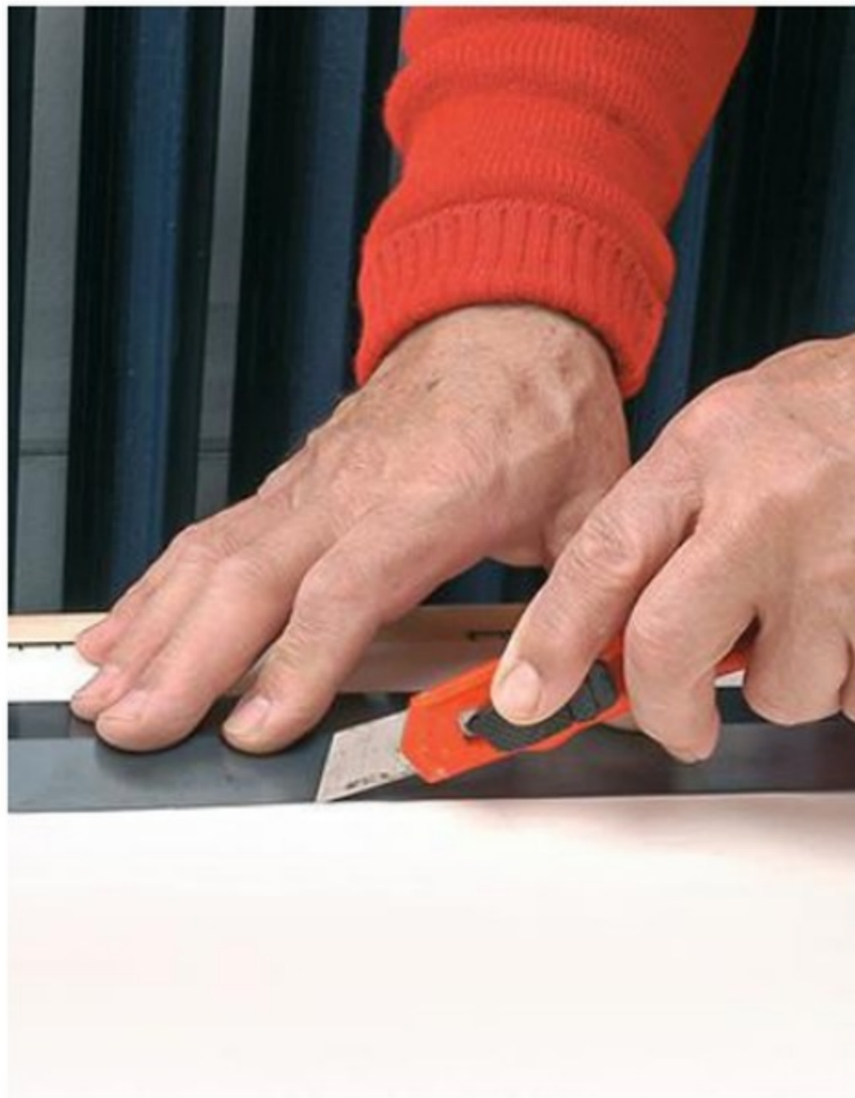
5 En vous guidant sur un réglet métallique, réalisez l'entaille à l'aide d'un gros cutter. Attention aux doigts, la lame coupe comme un rasoir !
