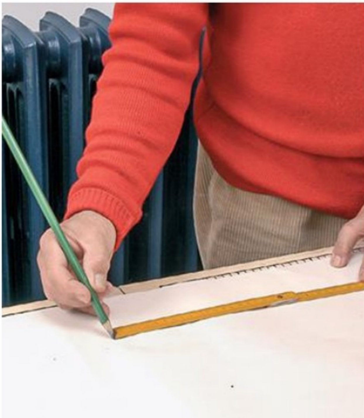
4 Tracez de la même façon le repère de hauteur de positionnement de la platine, majorée de quelques centimètres pour conserver la marge utile à l'arasement du lé en pied.
