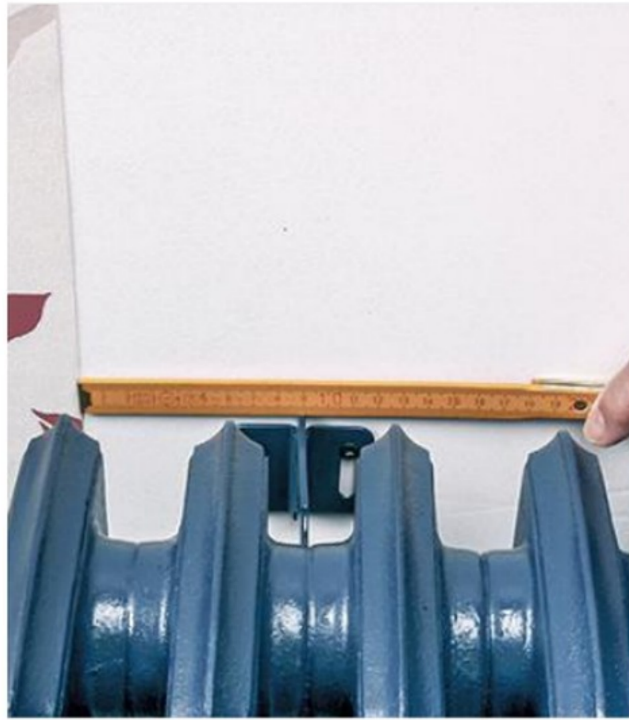
2 Relevez ensuite avec précision la distance séparant le bord du lé déjà posé et la platine d'ancrage de la console. Pour ce faire, un mètre pliant est préférable.
