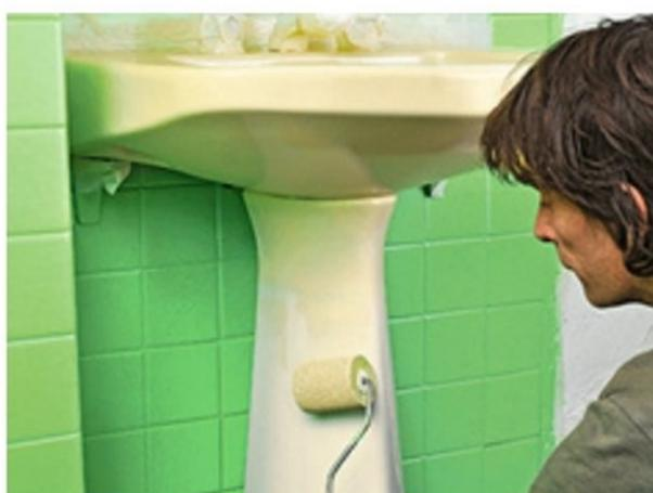
**6/** Poursuivez sur les surfaces plus larges à l'aide d'un rouleau en mousse. Laissez sécher 24 heures.
