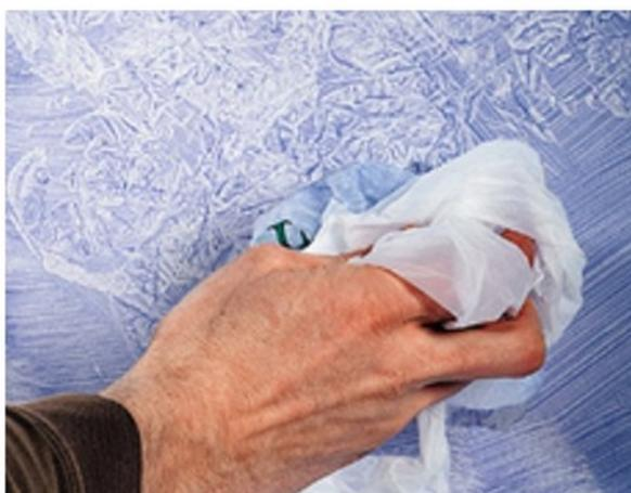
Utilisez un sac en plastique roulé en boule pour réaliser un effet froissé. Faites-le pivoter au fur et à mesure de l'application pour obtenir une certaine irrégularité. Changez de plastique lorsqu'il est trop imbibé de peinture.
