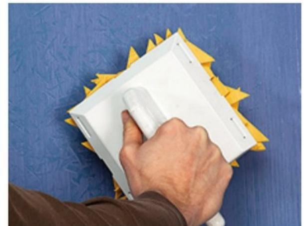
**1/** Parmi les outils capables de réaliser des effets muraux, les tampons sont en bonne place. **Composé d'une peau froissée collée sur mousse**, celui-ci permet de créer des effets variés. Il se déplace sur le mur de manière irrégulière en changeant l'inclinaison au fur et à mesure de l'application.
