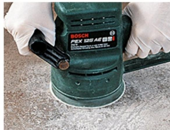
**2/** Nivelez les petites irrégularités avec une ponceuse excentrique équipée d'un disque à gros grains.
