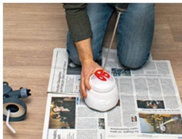
**5/** La dilution de la peinture s'effectue à l'aide d'un mélangeur monté sur perceuse. Elle est réalisée dans le godet (1 l) comme dans le réservoir (10 l) ou directement dans le pot de peinture.
