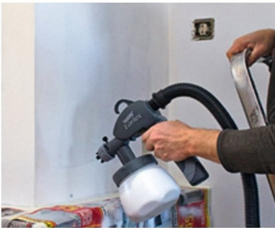
**10/** Pour traiter un angle sortant, **l'utilisation du jet plat horizontal est à privilégier**. En se plaçant face à l'arête, la peinture est pulvérisée uniformément de part et d'autre de celle-ci.
