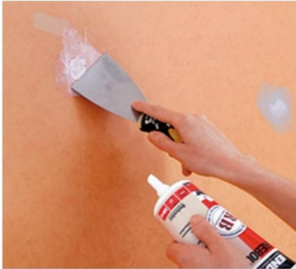
**3/** Rebouchez les trous laissés par les chevilles et les accidents de surface en appliquant directement l'enduit sur le papier peint. **Laissez sécher et durcir (24 heures)** avant de poncer avec un abrasif moyen.
