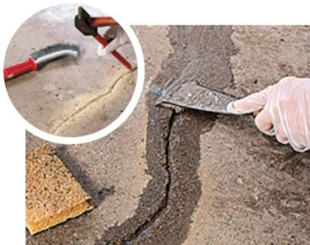
**1/** Ouvrez les fissures au burin sur 1 cm, puis rebouchez-les avec un mortier de réparation.
