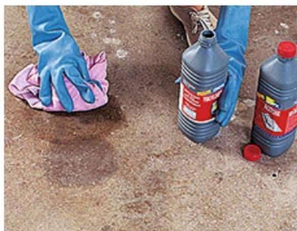
**3/** Le support doit être aussi propre que possible. Nettoyez-le avec un détergent, puis insistez sur les traces de graisse avec de l'acétone.
