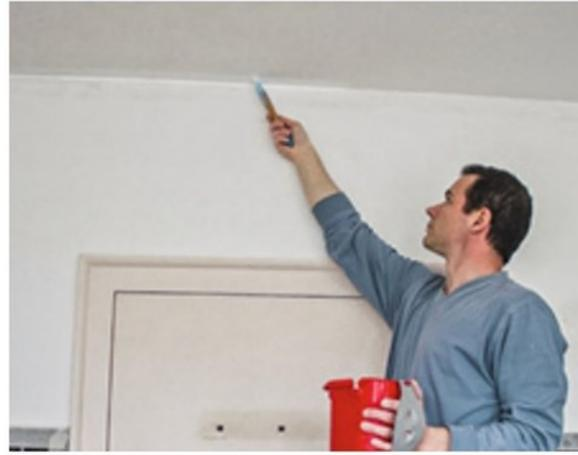
**2/** Commencez par la jonction plafond-mur avec une brosse plate. **Faites le tour du plafond à la première passe** puis au fur et à mesure de l'avancée lors de la seconde couche.
