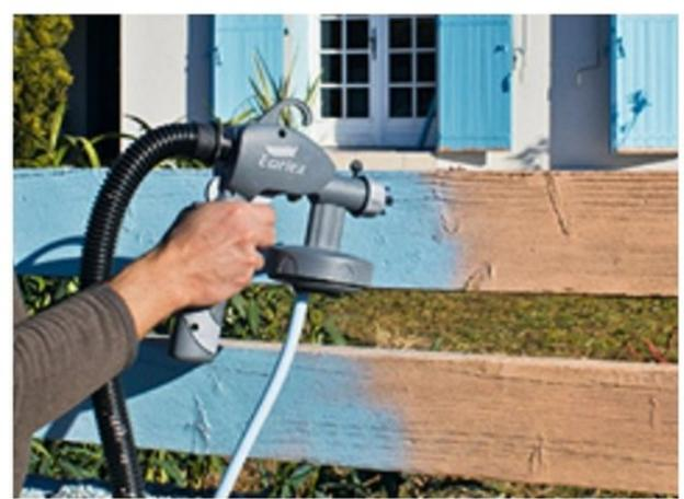
**12/** Le jet plat vertical convient parfaitement pour **pulvériser la peinture sur des éléments horizontaux** de faible hauteur. Ici, il permet de peindre uniformément une clôture dans le sens du fil du bois.
