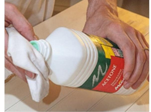
**2/** Lessivez les surfaces. Rincez abondamment à l'eau tiède, **puis dégraissez-les** en utilisant un chiffon imbibé d'acétone.
