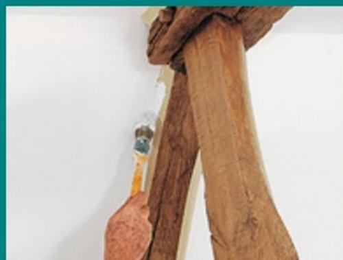
Délimitez la surface avec un ruban pour ne pas déborder d'un panneau sur l'autre ou sur un élément de structure.
