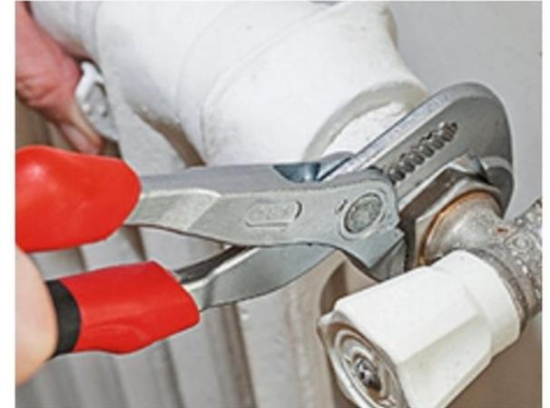
**3/ Dévissez l'écrou** situé à côté du robinet d'alimentation. Puis **écartez les tuyaux** en forçant légèrement afin de libérer l'appareil.
