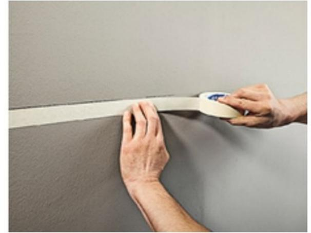
**3/** Collez l'adhésif de masquage jusqu'à l'angle opposé. Placez-le sous le tracé supérieur et au-dessus du tracé inférieur.
