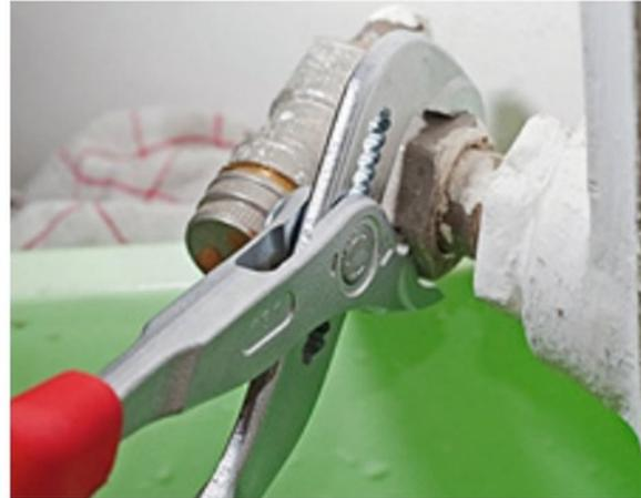
**2/ Placez une bassine** sous le radiateur. **À l'aide d'une clé, dévissez de quelques tours l'écrou** du retour chaudière.
