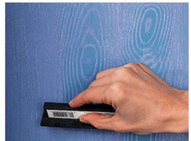
**1/** La boisette est un outil en caoutchouc conçu pour réaliser des motifs imitant le bois. **Raclez verticalement la surface du mur en faisant pivoter l'outil.** Le geste doit être délicat, pour obtenir le bon effet. Cela nécessitera sans doute de nombreuses tentatives avant de parvenir au résultat souhaité.
