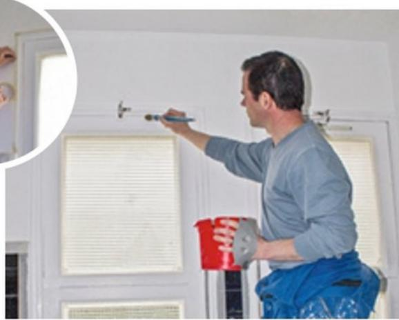
**4/** Passez deux couches sur les fenêtres à la brosse plate et à réchampir. Après séchage, **posez de l'adhésif de masquage au plafond** et sur le contour des fenêtres repeintes.
