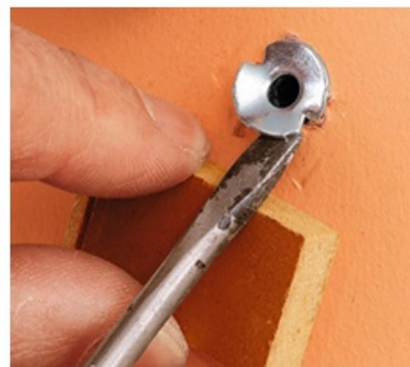
**2/** Pour faire disparaître une cheville métallique à expansion, **glissez la lame d'un tournevis sous la collerette** et faites-la sauter en prenant appui sur une cale pour faire levier.
