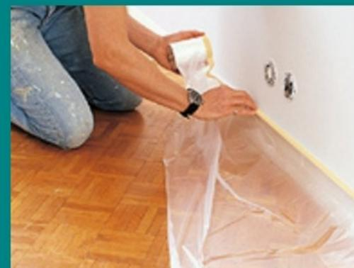
Fixez un film polyane au sol avec un ruban de masquage à placer au-dessus des plinthes si leur couleur diffère de celle des murs.
