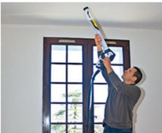
**13/** L'utilisation d'**une rallonge ou d'une lance permet de travailler depuis le sol sans escabeau**. Seule précaution, dégager au chiffon le cône de peinture sèche qui se forme au niveau de la buse.
