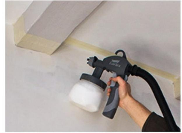
**9/** Pour dégager les angles rentrants, **le jet plat permet de couvrir les arêtes**. En utilisant le godet sous le pistolet, il s'agit d'orienter le tube plongeur coudé, en fonction de l'inclinaison du pistolet.
