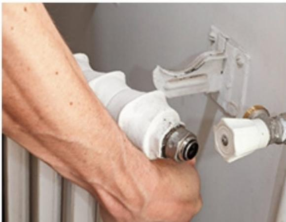
**4/ Déposez le radiateur. Inclinez-le contre un mur**, en protégeant celui-ci ainsi que le sol pour ne pas laisser de marques.
