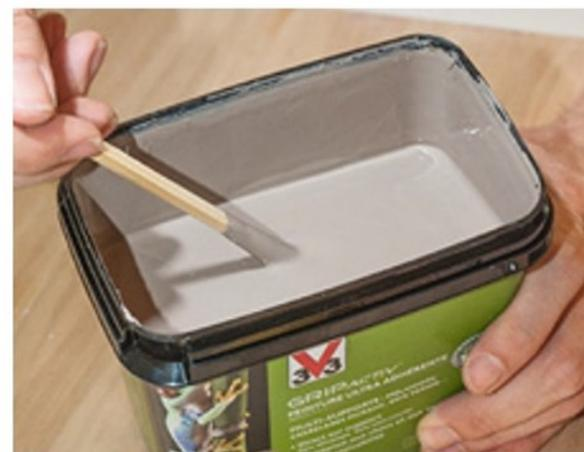
**2/** Mélangez la peinture **avec une baguette en insistant sur le fond pour l'homogénéiser**. Renouvelez l'opération régulièrement.
