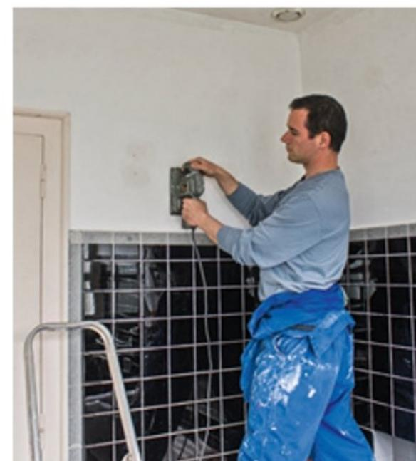
**6/ Une fois sec au toucher, poncez et dépoussiérez après chaque passe d'enduit.** Travaillez à la cale à poncer ou à la ponceuse vibrante avec un grain de plus en plus fin.
