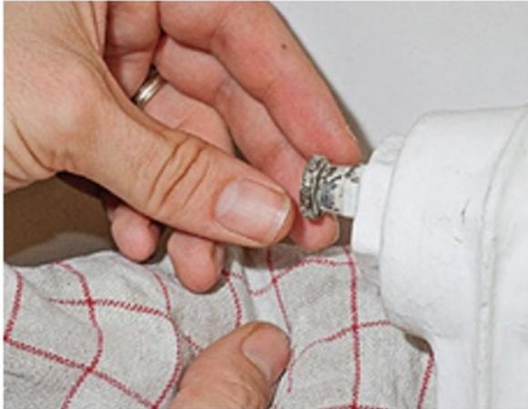
**1/ Fermez le robinet** ainsi que le retour chaudière en bas. Ouvrez la vis de purge pour permettre à l'air de sortir du radiateur.
