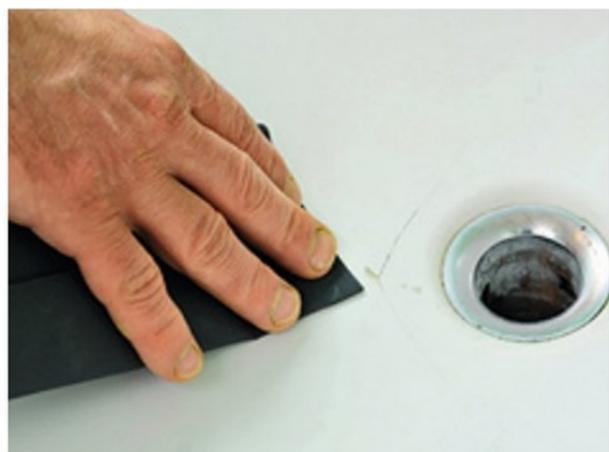
**1/** Poncez le lavabo, dépoussiérez, nettoyez à la lessive de soude, puis dégraissez avec de l'alcool à brûler.
