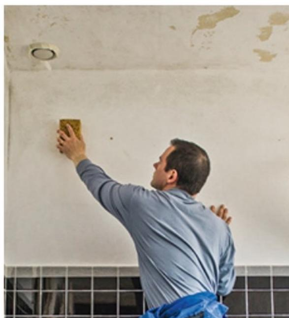
**4/ À l'aide d'une large éponge de chantier, lessivez les murs et le plafond** avec un détergent adapté. Rincez abondamment puis laissez sécher.
