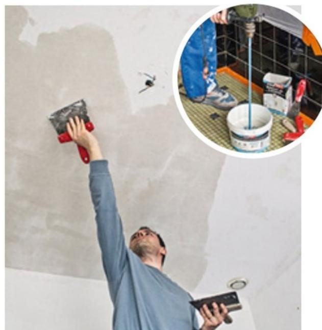
**5/ Dans un récipient, préparez l'enduit** avec un malaxeur monté sur une perceuse. **Appliquez-le à l'aide d'un large couteau à enduire.**
