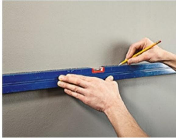
**2/** Au niveau à bulle, tracez la limite supérieure puis inférieure de la bande centrale. Utilisez un crayon à papier bien taillé.
