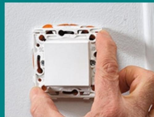
Ne contournez pas interrupteurs et prises. Démontez les plaques de finition et peignez autour.
