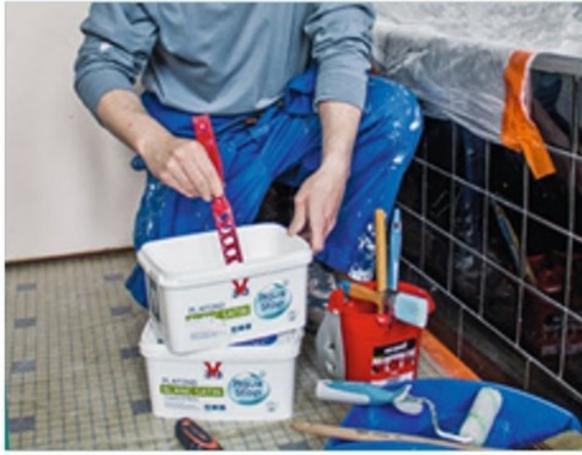
**1/** Brassez la peinture de finition au mélangeur manuel ou monté sur une visseuse **afin de répartir uniformément les pigments** et obtenir une peinture bien homogène.
