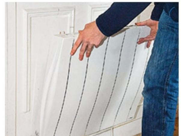
**9/** Pour peindre le mur facilement, déposez les radiateurs. **Poncez-les légèrement**, puis passez deux couches de peinture avec une brosse coudée.
